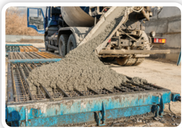
7. ábra. A vasbeton alapozás elkészítése
